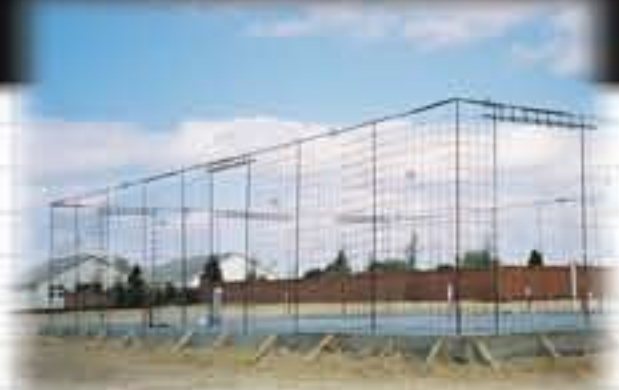
Antes de montar las formaletas se realiza un reforzamiento estructural
