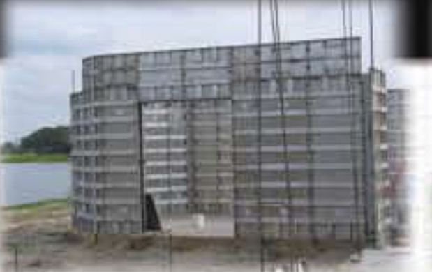
Los espacios para puertas y ventanas, grandes o pequeñas, se ubican con facilidad
